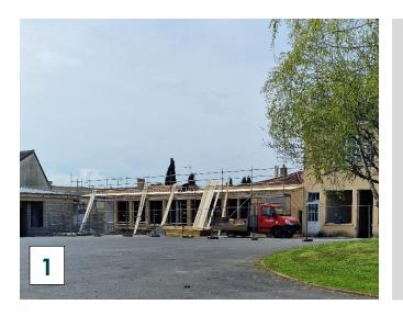
1- Au lycée professionnel, la couverture en zinc des futurs ateliers pour accueillir les locaux du CAP IMTB, est en cours de réalisation ; à suivre, le coulage de la dalle qui mettra au même niveau l'ensemble.
